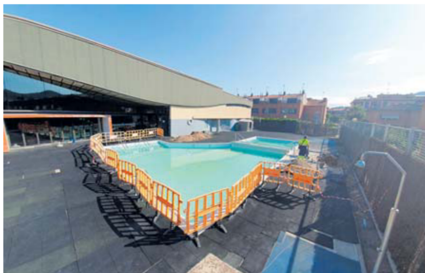
Imatge de la piscina exterior de Montcada Aqua, tancada des del passat estiu a causa d'un problema de fuites d'aigua quan s'omple el vas íntegrament
